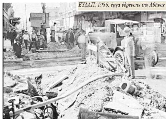
ΕΥΔΑΠ, 1936, έργα ύδρευσης της Αθήνας
