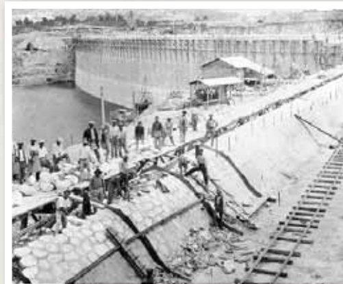
Κατασκευή του Φράγματος στη λίμνη Μαραθώνα
